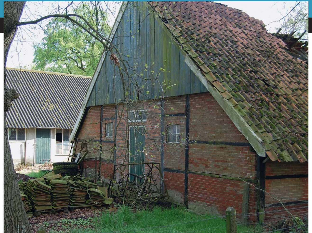
Te transformeren stal en erf in Dinkelland
